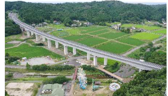
常磐自動車道大久川橋
