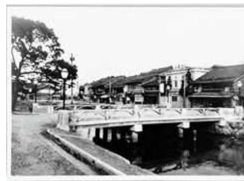
長生橋（石川県七尾市）
