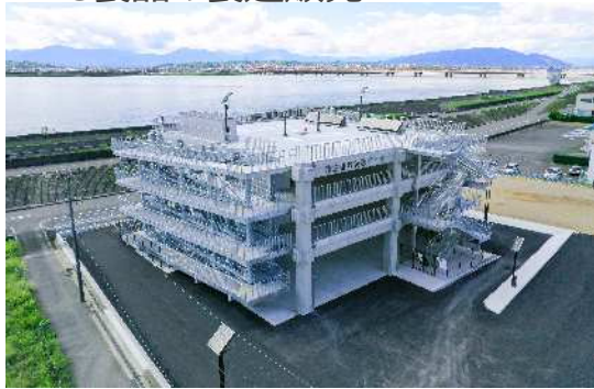
桑名市津波避難施設
