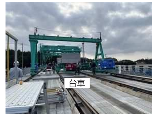
台車を用いたPCaPC床版の運搬
