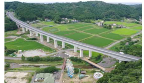
常磐自動車道大久川橋
